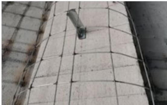
▲图 4.3-2 钢骨架安装方式 2-2
