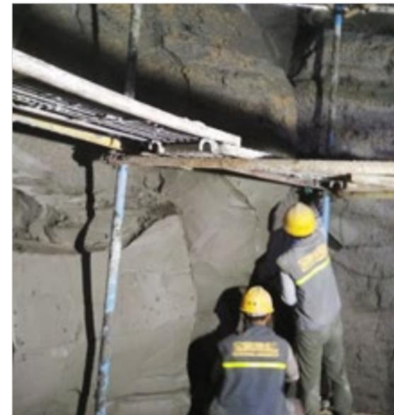
▲图 4.6-2 面层砂浆塑型造型
