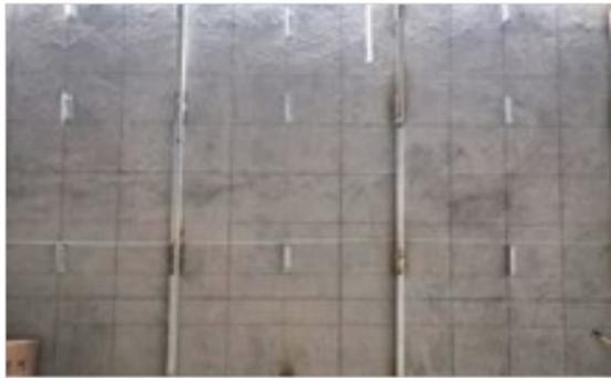
▲图 4.3-2 钢骨架安装方式 2-1
