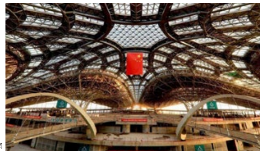
采光顶区域原结构现场图
