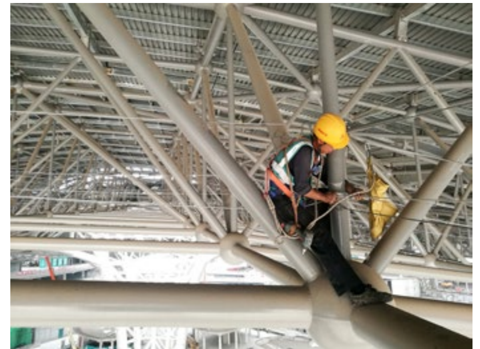
安装高空作业安全绳
