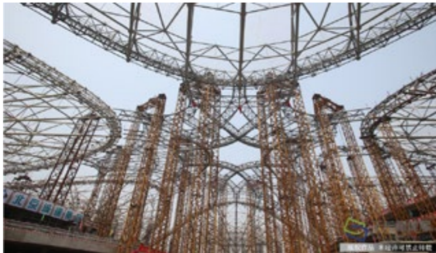
采光顶钢结构现场图
