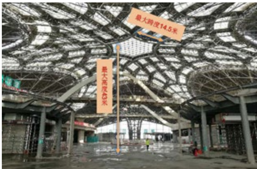
采光顶最高点高度为 43 米，球节点间最大跨度 14.5 米。
