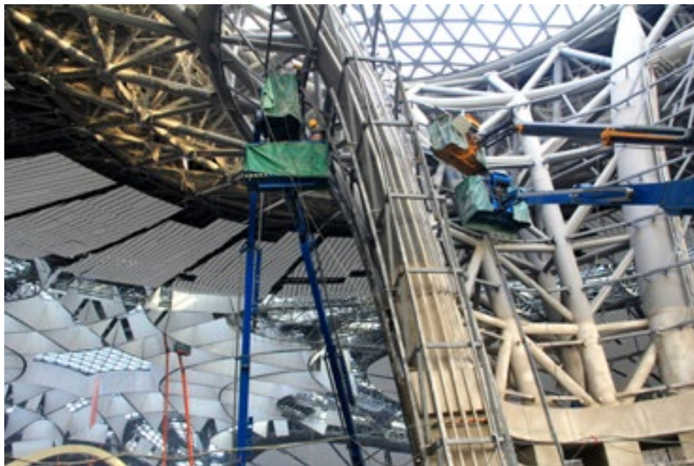
现场装配化安装
