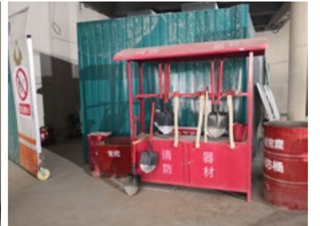
消防设施及器材
