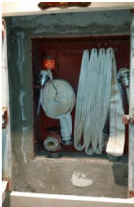
错误：装饰门的干挂骨架及箱体四周开启角度不足，栓口安装在门轴侧
