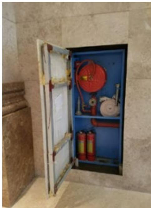
错误：装饰门的干挂骨架及箱体四周未封堵，栓口安装在门轴侧
