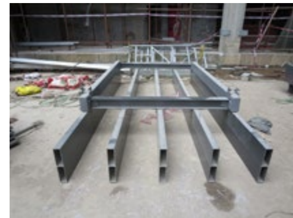
格栅单元板块的构成图
