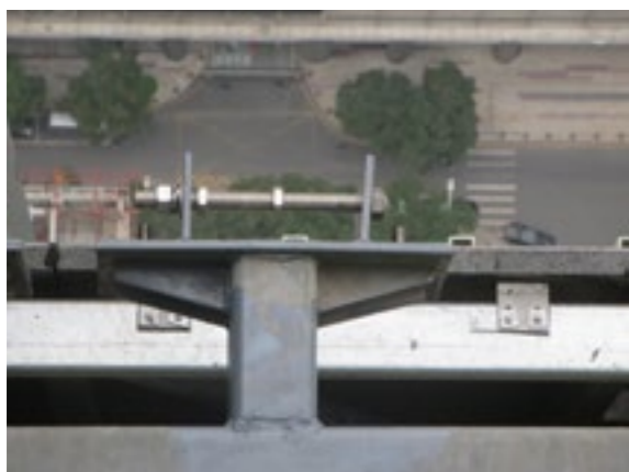
已安装好的支承结构
