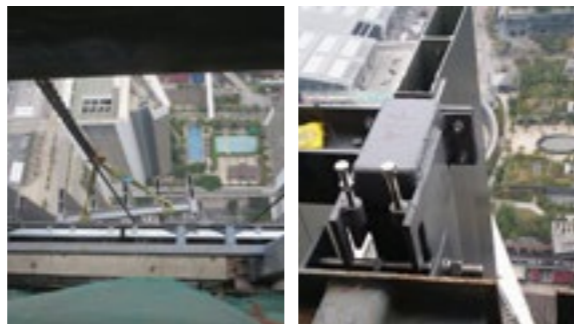
换钩后电动葫芦吊装 单元板块与支承结构对接
