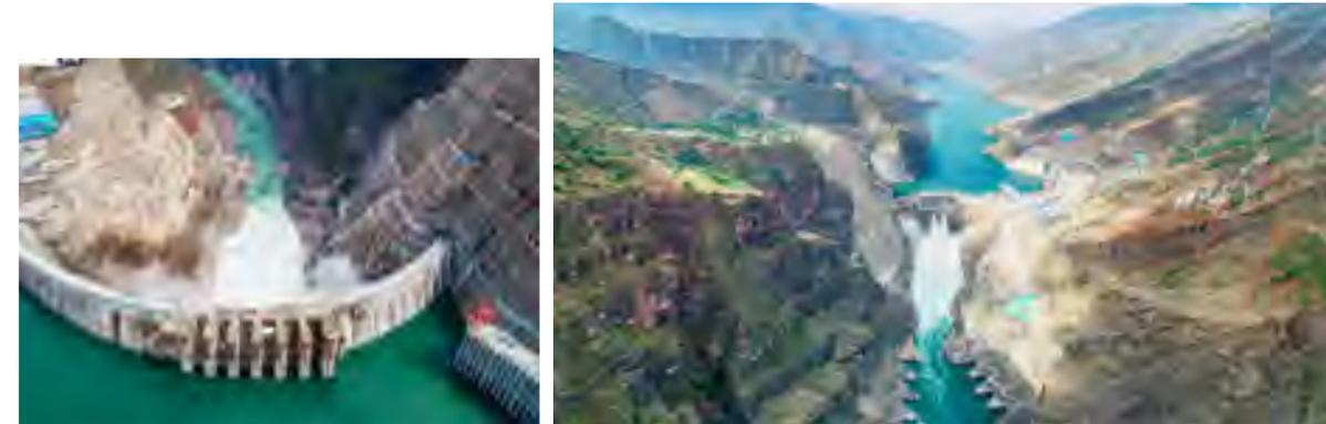
金沙江白鹤滩水电站是当今世界在建规模最大、技术难度最高的水电工程。水电站地处金沙江干热河谷地带，地质条件复杂，主要技术指标 6 项世界第一、水轮发电机单机容量为 100 万千瓦世界第一、地下洞室群规模世界第一、圆筒式尾水调压室规模世界第一、300 米级高拱坝抗震参数世界第一、无压泄洪洞群规模世界第一。该工程是三峡工程之后中国水电的新“国家名片”，在水电工程建设史上具有划时代的里程碑式意义。
