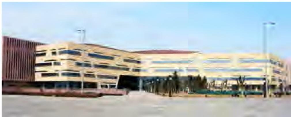
山西省图书馆位于太原市长风商务区文化岛，型钢混凝土框架结构，外形呈不规则L形布局，造型优美，形似书山，室内空间立体感强。建筑风格舒适宁静、简约大方，并彰显了山西院落建筑文化与现代建筑理念的完美结合。
