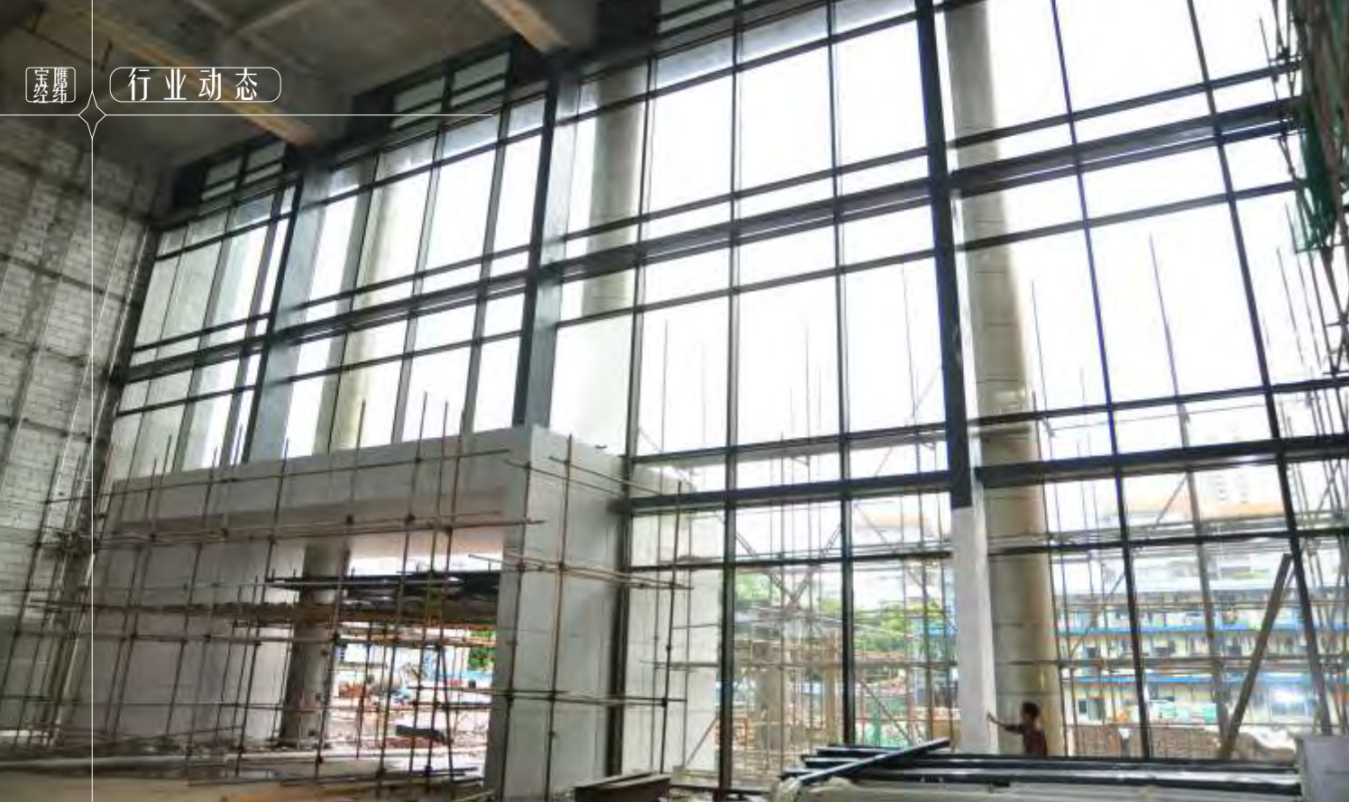
▲集团在建的幕墙内部结构
