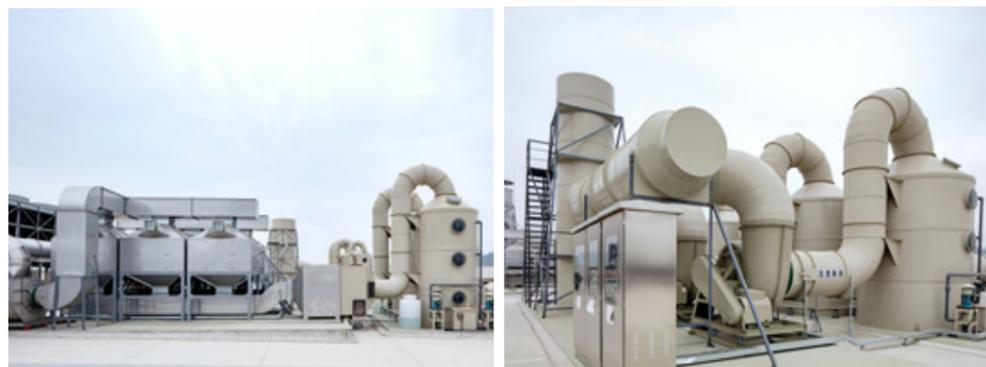
废气处理系统包括酸性废气、碱性废气、有机废气、热排废气，废气排放为避免泄漏，因此对管道严密性有着极高的要求，同时为了避免废气污染环境及损害人体健康，生产设备产生废气均抽至屋顶由多台洗涤塔处理至排放标准。生产设备产生粉末、碎屑等均由集尘系统进行收集处理，避免造成粉尘污染，同时回收利用金属粉尘。
