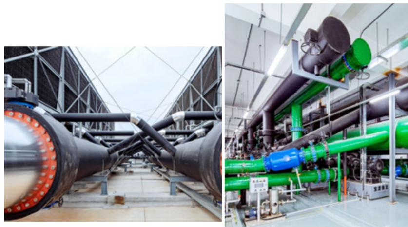
项目部为 4350 RT 的制冷机房设计 5.0 高效机房，经过精准的阻力计算，变频调节，实现制冷主机、水泵、冷却塔能耗最小化，最大限度降低能耗，降低排放，实现高效节能的目的。
