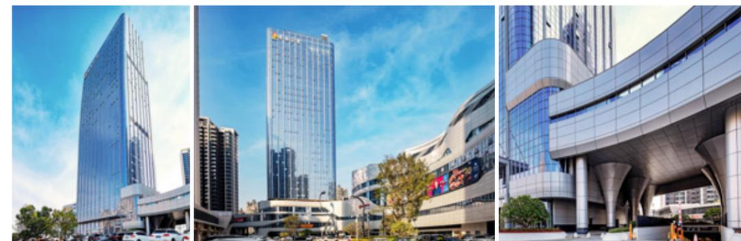
惠州隆生金山湖中心占地 53 万平方米，是广东惠州金山新城地标级综合体生活大城，涵盖甲级写字楼、高档住宅区、大型购物中心。中心幕墙最高标高为 148.250 米，属于钢筋混凝土框架剪力墙结构。
