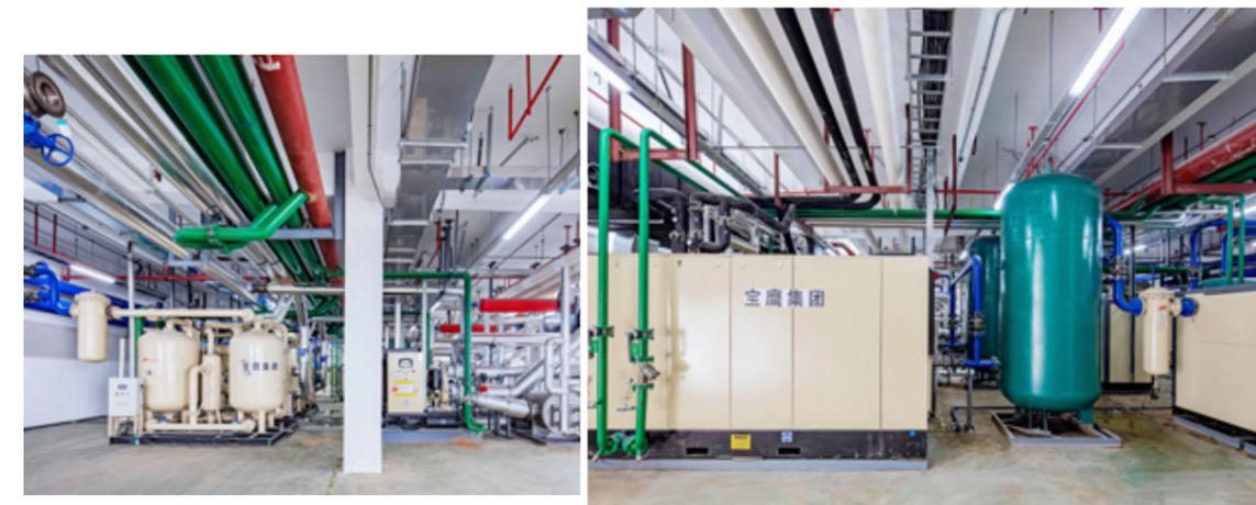
工艺冷却水及高温热水系统包含7/12℃、14/19℃、18/23℃、30/35℃、40/45℃、60/65℃、87/92℃七种系统水温，主要用于冷却业主生产设备。水温的过高与过低均会影响业主生产设备的精密度，直接性影响到成品的质量标准，因此工艺冷却水系统对水温的控制有着严格的要求。
