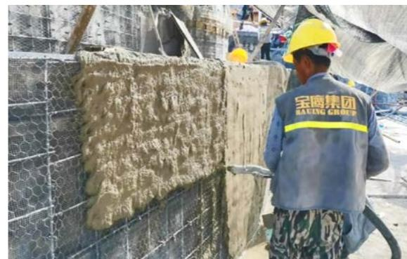
▲图 3.1.1-1 底层砂浆喷筑
