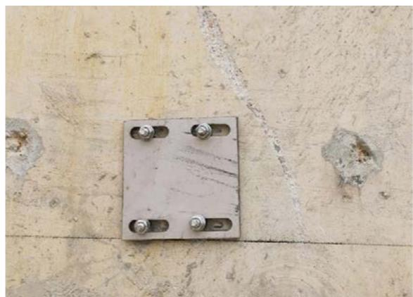
▲图 2.1.2-1 后置埋板安装
