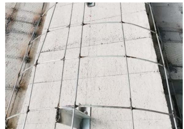
▲图 2.2.1-2 角钢骨架安装
