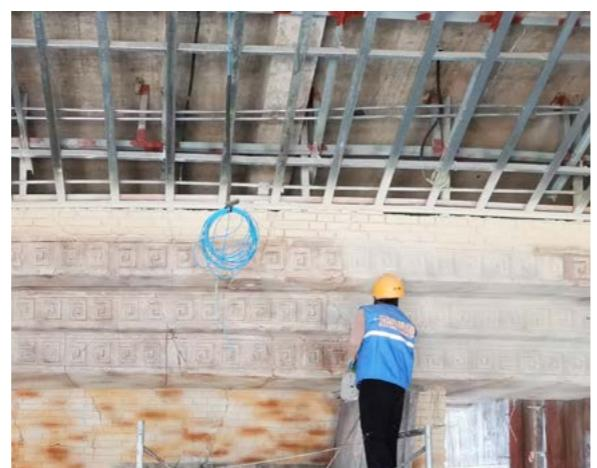
▲图 4.1.2-1 喷涂封闭底漆
