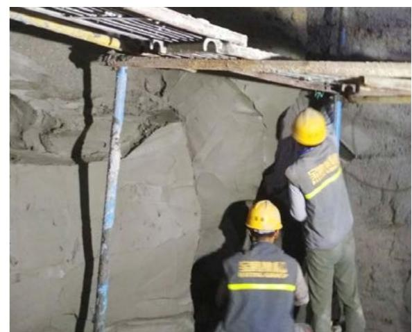
▲图 3.3.2-1 面层砂浆初步造型轮廓塑造
