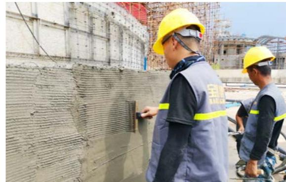
▲图 3.2.1-1 底层砂浆拉毛
