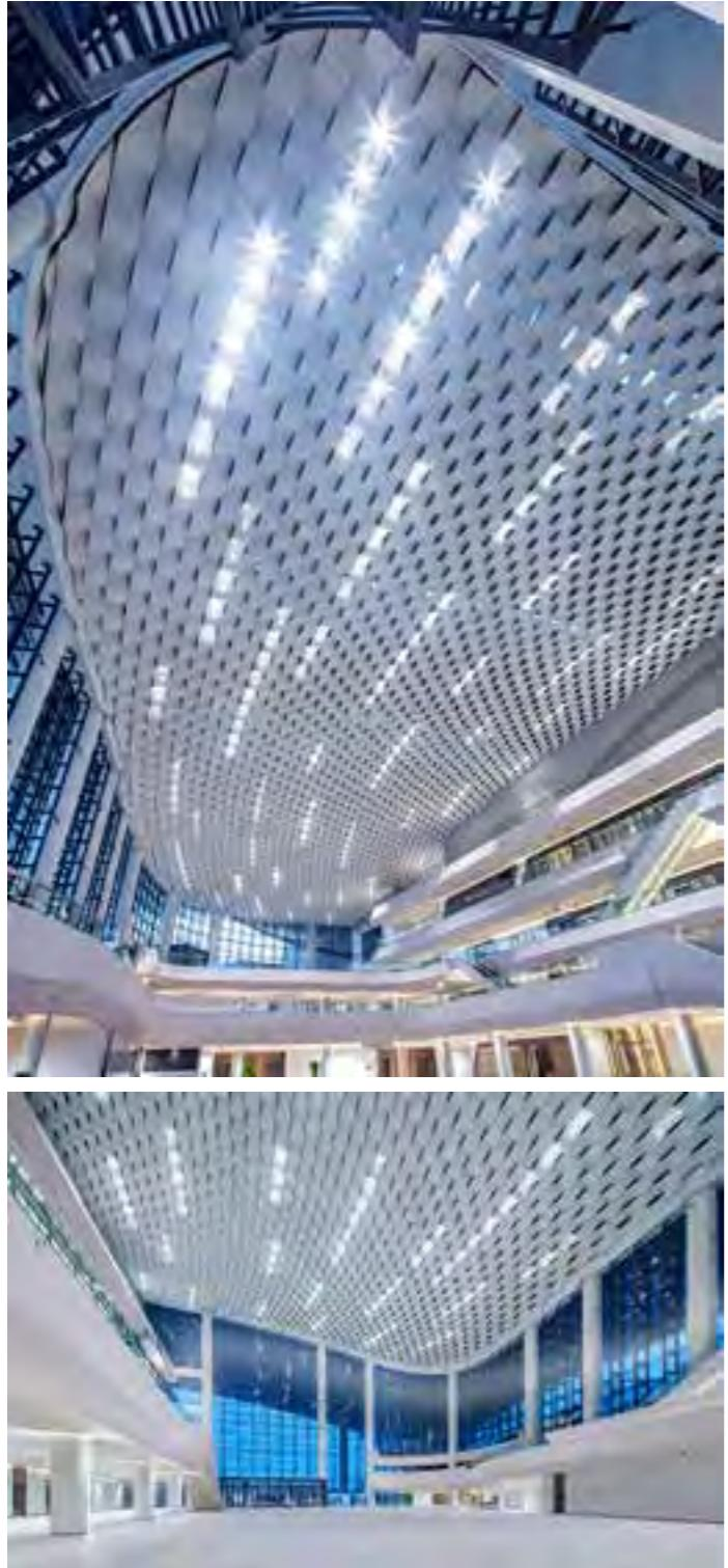
整个主登录厅最具特色的当属那 50 米高空处由 1976 块波浪形蜂窝铝板组成的波浪吊顶。因此，主登录厅成为了整个项目精装修工程中高空顶面最大、施工难度最大、工艺最复杂的标段。
