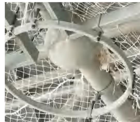
▲ 图8 网架或钢结构屋架吊顶转换层系统
