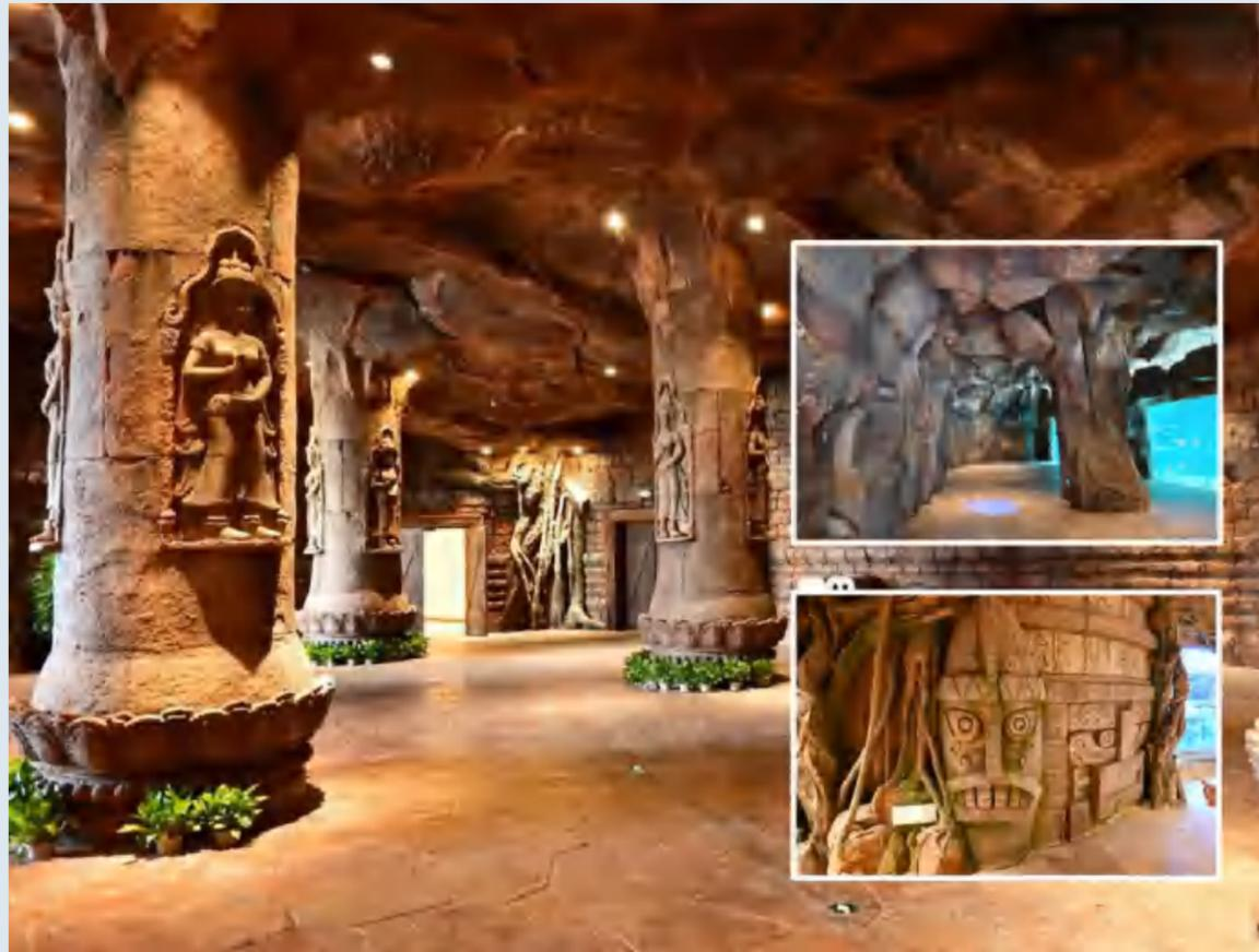
为了解决天然石材、木材等传统饰面材料在生产、施工过程中的弊端和难点，宝鹰集团通过一系列的探索研究，经过实验总结逐步形成了仿真造型水泥塑型施工技术。
