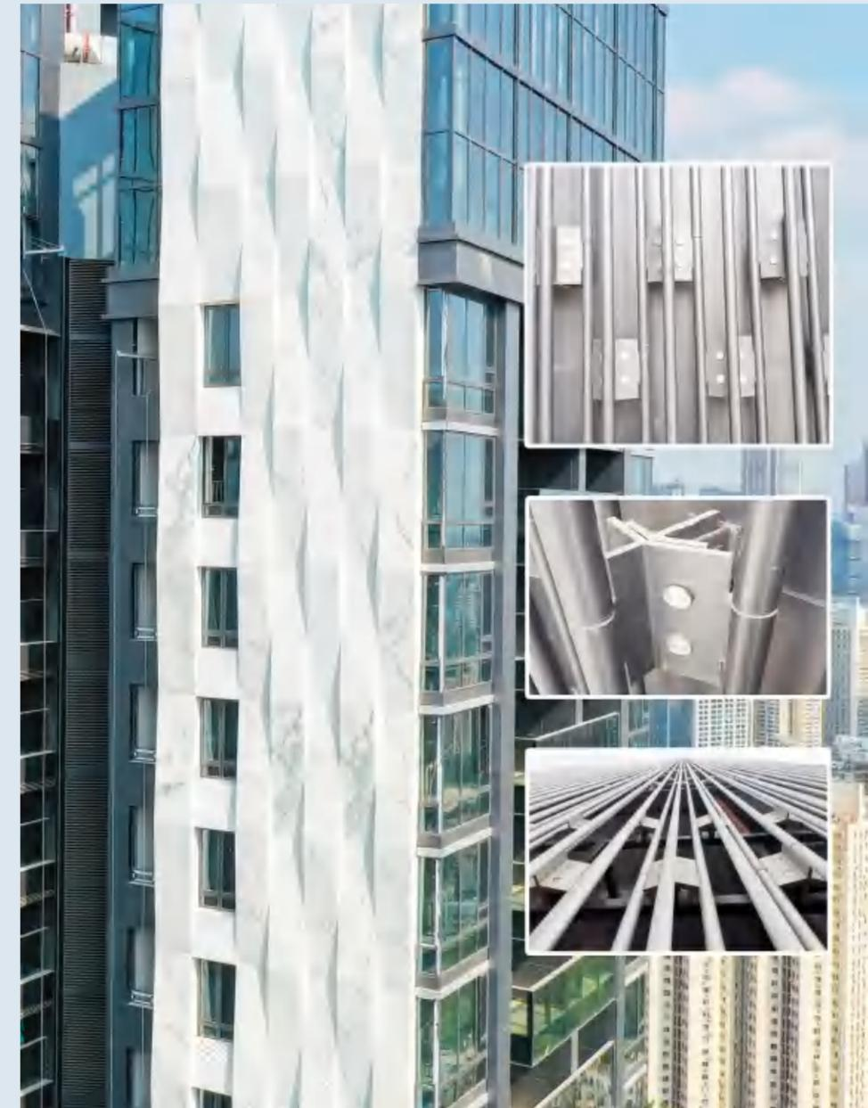
为了解决扁管形、方管形等传统格栅幕墙施工的安装技术难题，宝鹰集团通过项目施工安装实践，积累了丰富的实践经验，取得了“圆管格栅幕墙施工技术”的研究成果。
